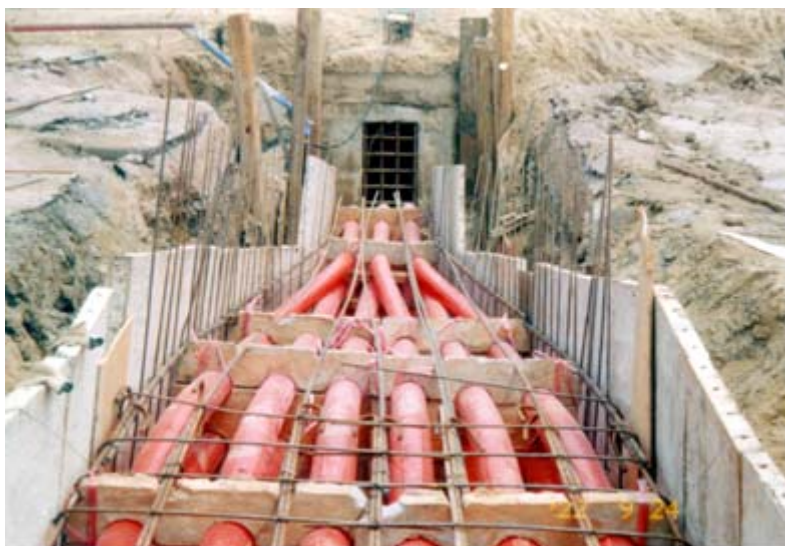
รูปที่ 2.4 ร้อยท่อฝังดิน (Semi-Direct Burial)
