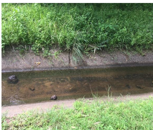
รูปที่ 4.13 สภาพท้องคลองที่มีลักษณะเป็นหินขนาดเล็กปนทราย
