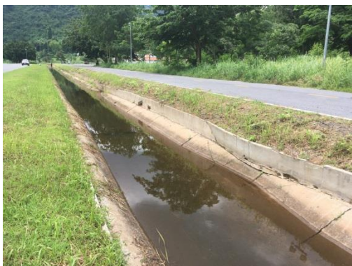
รูปที่ 4.11 รูปรอยร้าวของคลองส่งน้ำสายซอย 1 ขวา
