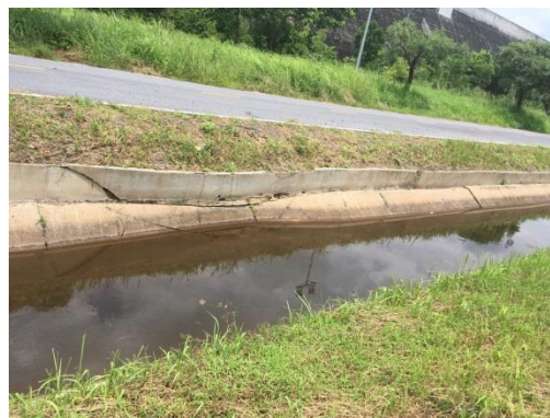
รูปที่ 4.11 รอยร้าวของคลองส่งน้ำสายซอย 1 ขวา
