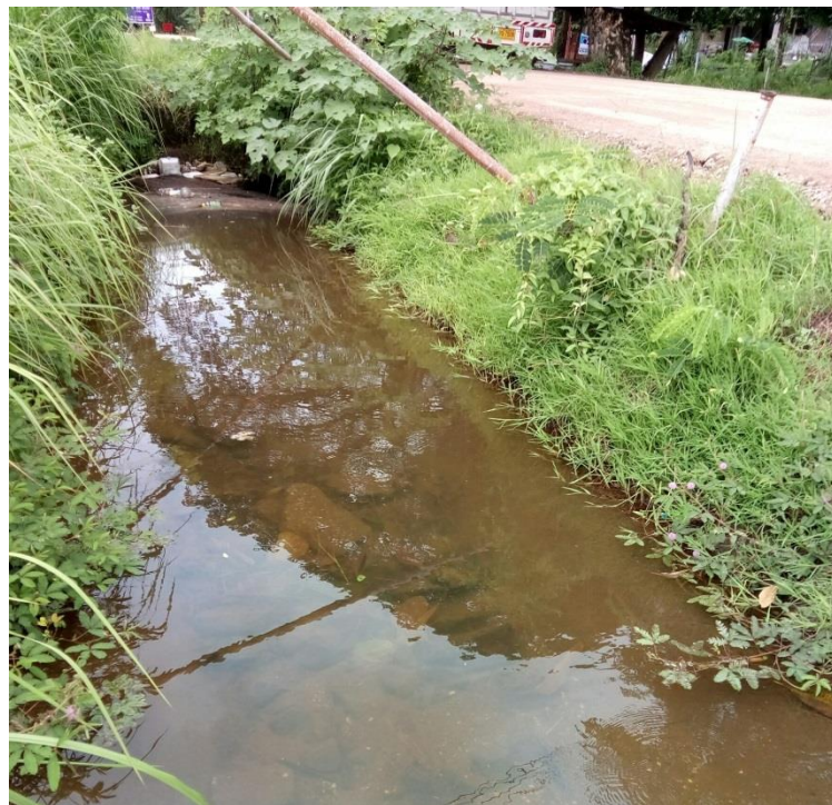
รูปที่ 4.18 วัชพืชกีดขวางทางไหลของน้ำในท่อลอดถนน
