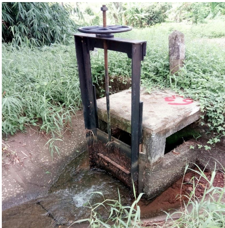
รูปที่ ข-9 ประตูปะบายน้ำออกท้ายคลอง
