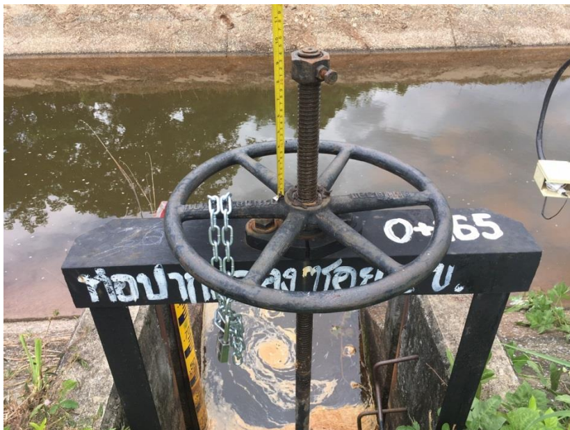
รูปที่ ข-7 ประตูระบายน้ำปากทางที่นำน้ำเข้าสู่ระบบ
