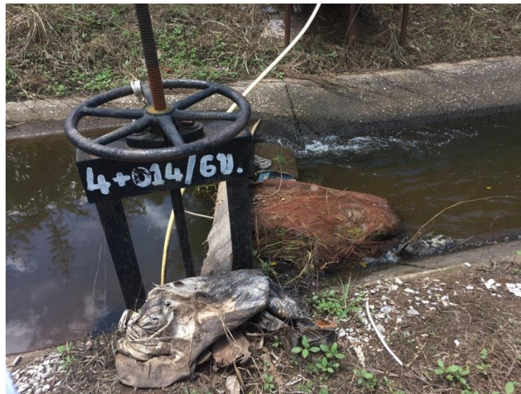
รูปที่ ข-5 มีสิ่งกีดขวางทางไหลน้ำ
