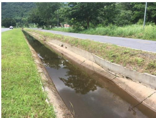
รูปที่ 4.11 รอยร้าวของคลองส่งน้ำสายซอย 1 ขวา
