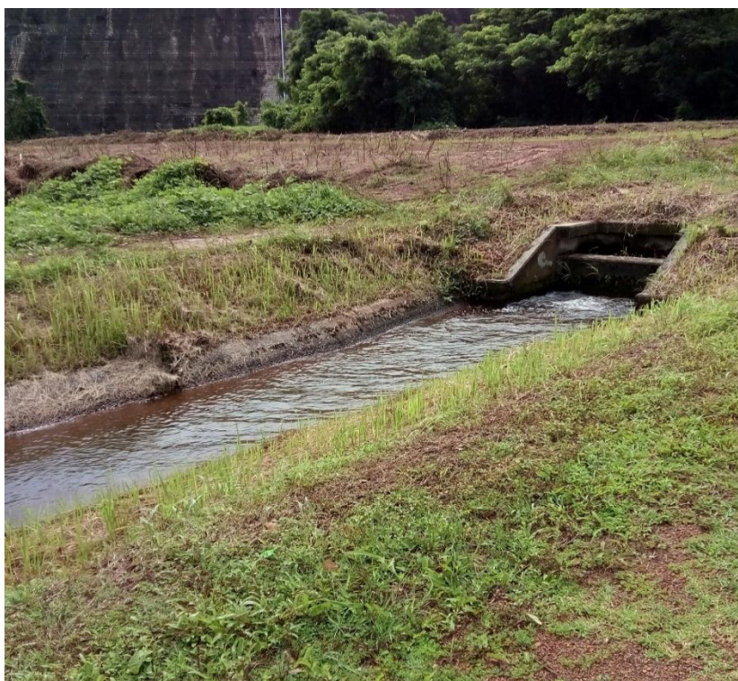
รูปที่ ข-8 ทำประตูระบายน้ำที่นำน้ำเข้าสู่ระบบ
