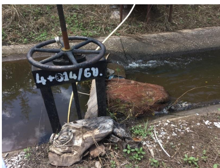
รูปที่ 4.16 รูปการนำแท่งคอนกรีตหรือไม้มาขวางทางน้ำเพื่อยกระดับน้ำให้สูงขึ้น
