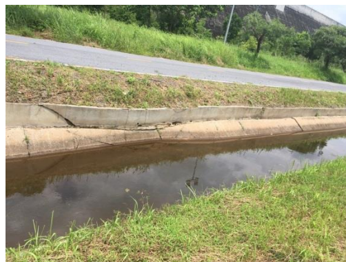
รูปที่ 4.11 รูปรอยร้าวของคลองส่งน้ำสายซอย 1 ขวา
