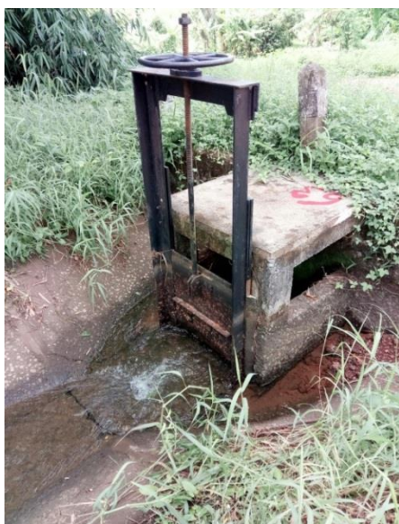
รูปที่ 4.25 ประตูประบายน้ำปลายคลองที่ระบายออกจากระบบและท้ายประตูประบายน้ำ
