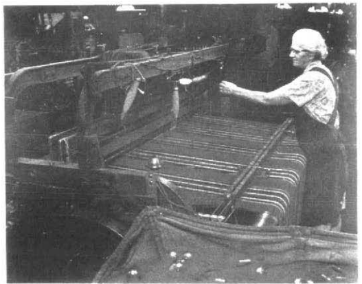
การใช้เครื่องจักรช่วยในการทอผ้าขนสัตว์
