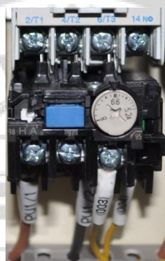
ภาพประกอบ 40 Thermal Overload Relay ยี่ห้อ Mitsubishi รุ่น TH-N12, 5.2-8A
