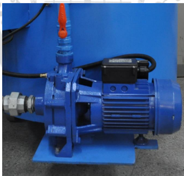
ภาพประกอบ 53 ปั้มน้ำชนิด Centrifugal ขนาด 2 แรงม้า
