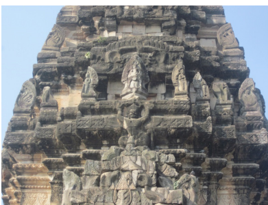
ภาพที่ 12 การทำชั้นวิมานและประดับนาคปัทม์ในปราสาทเขมร (ปราสาทหินพิมาย)
