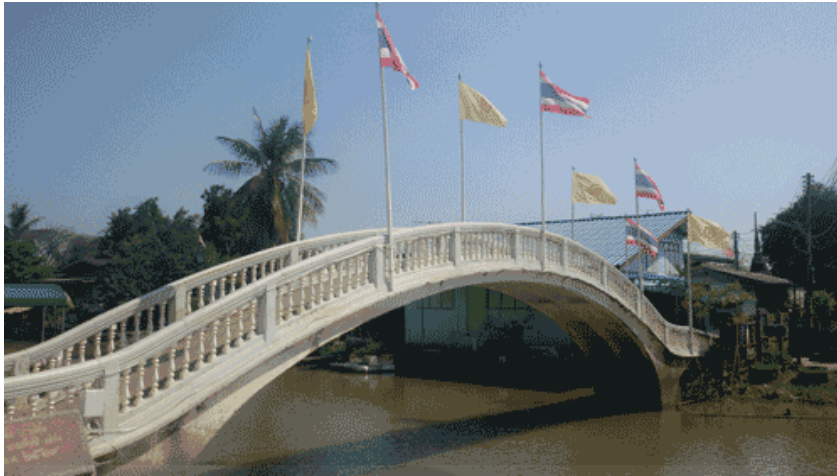
ภาพประกอบ 40 ภาพแสดงสะพานโค้ง 100 ปีที่วัดบางหลวง จังหวัดปทุมธานี ที่มา : เทศบาลตำบลบางหลวง อำเภอเมือง จังหวัดปทุมธานี. (2557). วัดบางหลวง. สืบค้นจาก http://www.bangluangcity.go.th/2014-11-22-02-52-39/2014-11-19-05-30-50/2014-11-20-11-07-16
