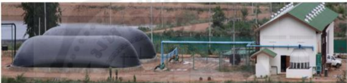
รูปแสดงโรงไฟฟ้าก๊าซชีวภาพระบบ Modified Covered Lagoon ขนาด 3 MW บริษัท ทีเอสเอ็มไบโอเอ็นเนอร์ยีจำกัด
