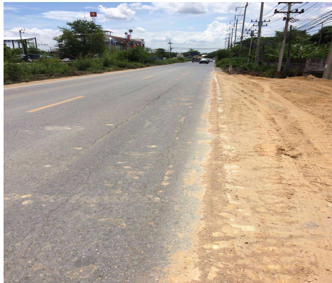
รูปที่ 4.9 สภาพถนนทางหลวงชนบท นย.3001 (ถนนที่ผ่านหน้าตลาดองครักษ์) ในปัจจุบันที่มีการ เสื่อมสภาพ
