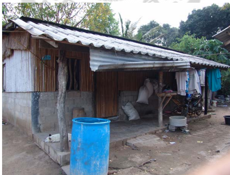
ภาพประกอบ 19 ลักษณะแบบบ้านบ้านผापกที่ใช้ไม้ไผ่ปลูกผสมกับอิฐบล็อก
