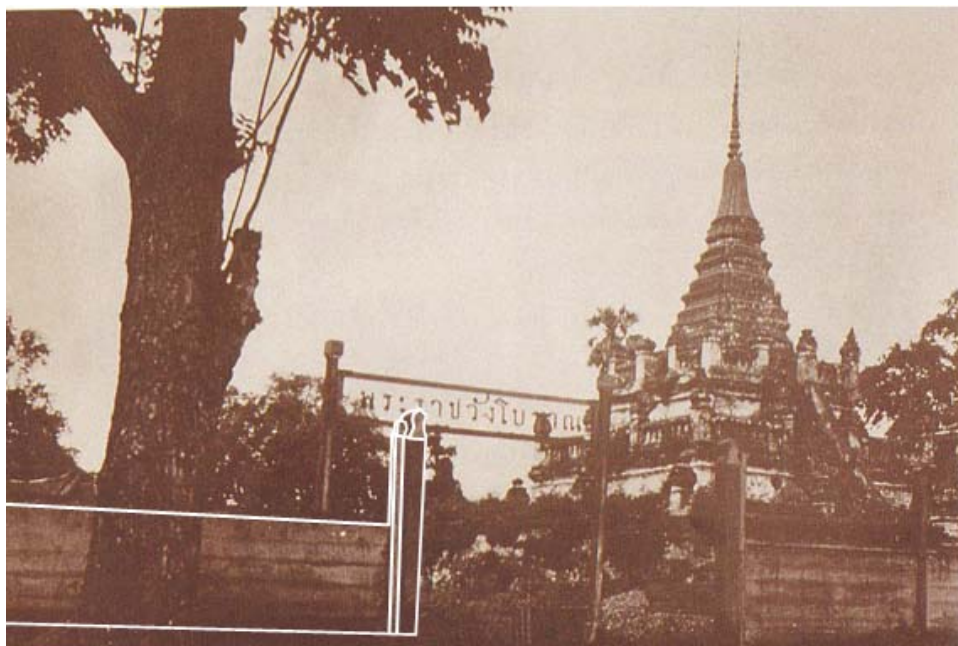
ภาพประกอบ ๑๕ รั้วคอนกรีตติดลวดหนามบริเวณพระราชวังโบราณ*
