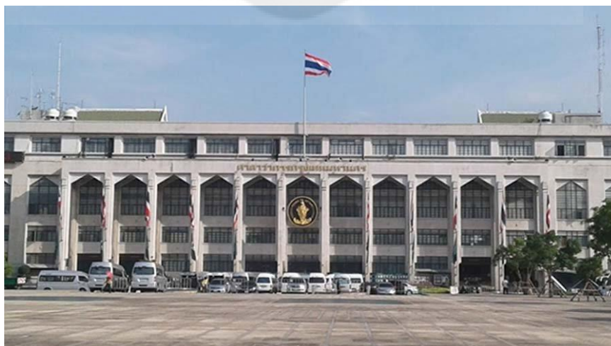
ภาพที่ 4 อาคารที่ทำการเทศบาลนครกรุงเทพ (ศาลาว่าการกรุงเทพมหานครในปัจจุบัน)
