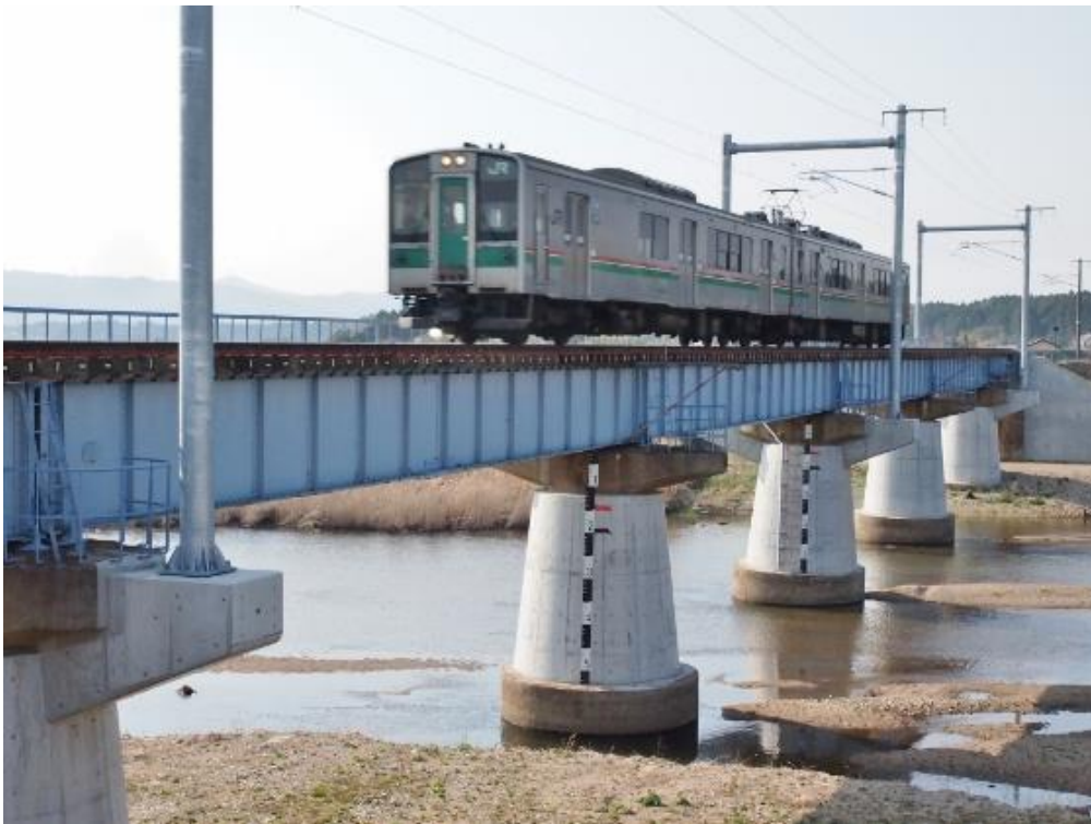
北からの浪江行きの電車が、最後に請戸川の鉄橋を渡るところ (2017年4月撮影) รถไฟจากทิศเหนือสู่เมืองนามิเอะ ก่อนถึงข้ามแม่น้ำอุเคะโตะ
