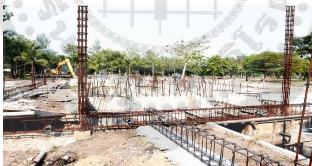
ภาพที่ 2.6 ตัวอย่างงานโครงสร้าง
