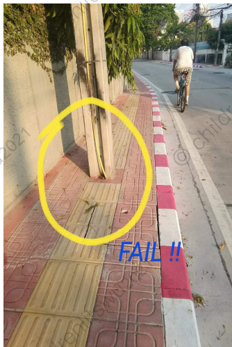
- เสาไฟฟ้าตั้งขวางทางเดินผู้พิการ
