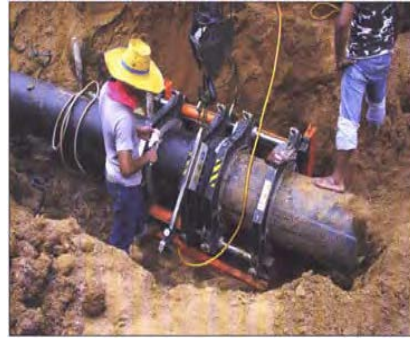
การต่อแบบเชื่อมด้วยความร้อน (Welding)
