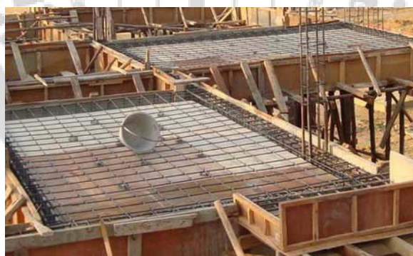
ภาพประกอบ 2 การผูกเหล็กและเข้าแบบ
