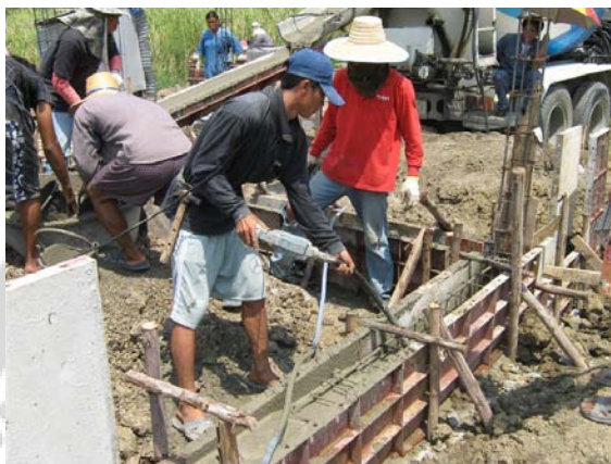
ภาพประกอบ 1 ช่างกำลังเทคอนกรีตลงในแบบ
