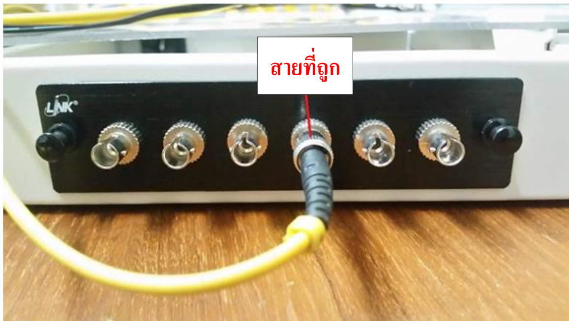
รูปที่ 4.8 แสดงการต่อสายถูก
