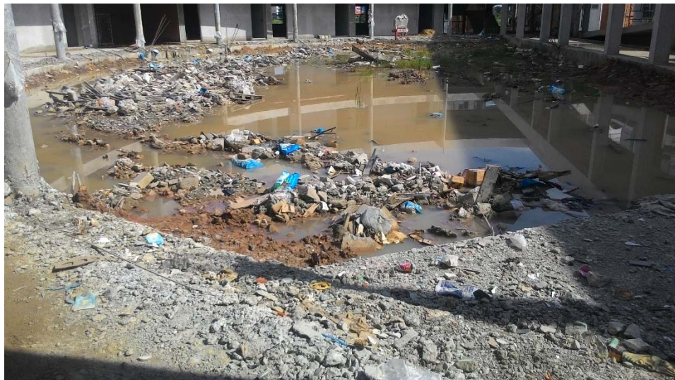
เศษปูนที่เหลือจากการก่อสร้าง
