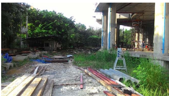
รูปที่ 4.1.15 กองเหล็กในพื้นที่ทำงาน
