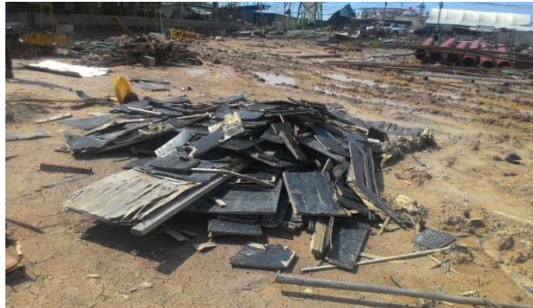
รูปที่ 4.3.9 กองเศษไม้แบบที่ชำรุด
