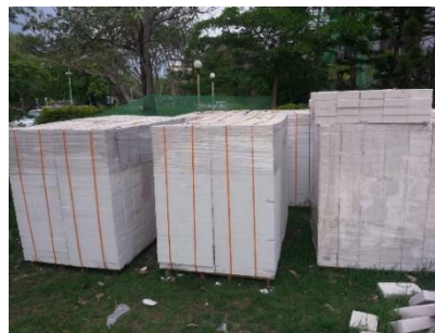
รูปที่ 4.1.22 การจัดเก็บคอนกรีตมวลเบา
