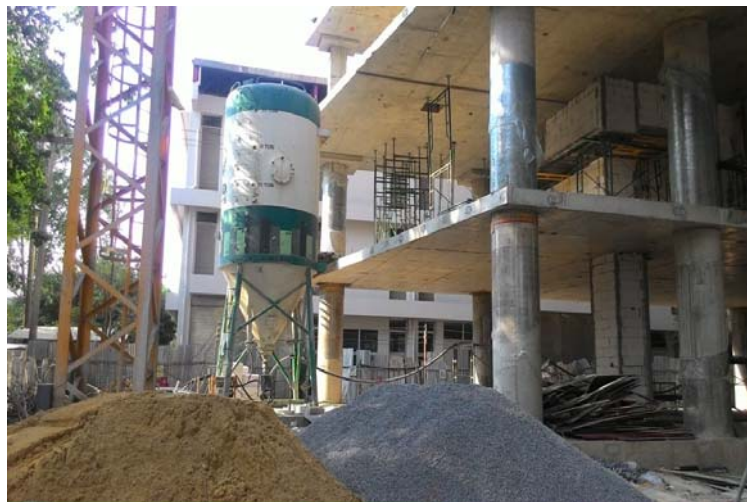
รูปที่ 4.3.8 ซิโลเก็บปูน และหินกับทรายที่พร้อมใช้ผสม
