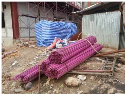
รูปที่ 4.1.17 กองเหล็กบริเวณก่อสร้าง
