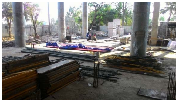
รูปที่ 4.1.5 กองเหล็กในพื้นที่ทำงานก่อสร้าง
