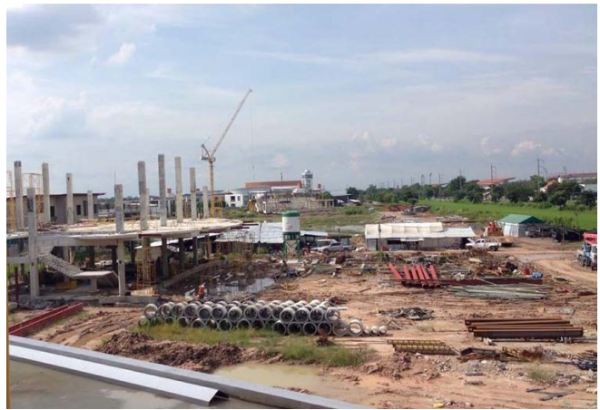
รูปที่ 4.1.9 การจัดวางและแยกประเภทในโครงการ
