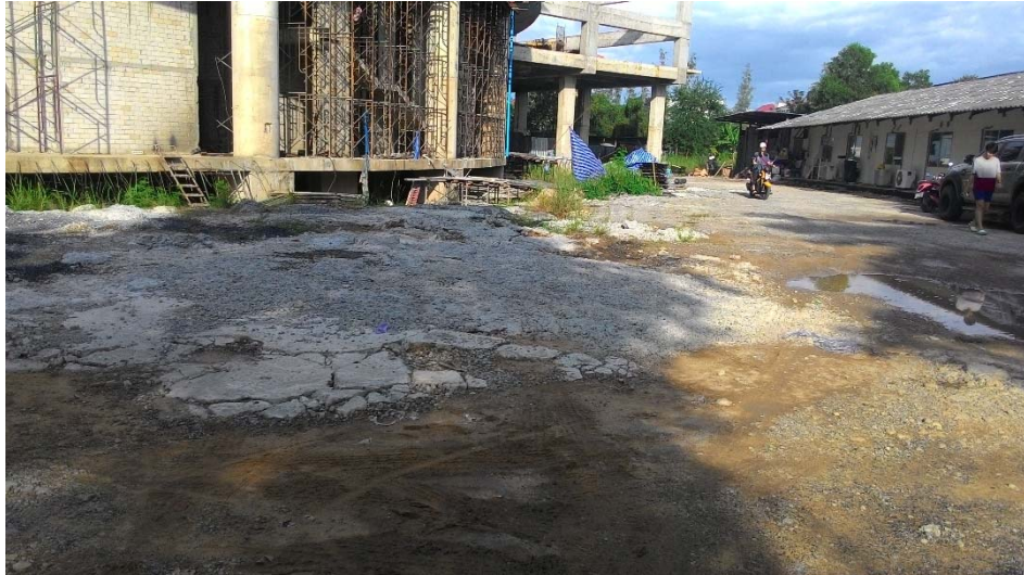
เศษปูนที่เหลือจากการก่อสร้าง
