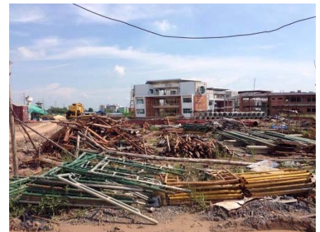
รูปที่ 4.1.12 กองนั่งร้าน
