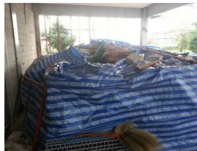
รูปที่ 4.1.20 กองเก็บปูนถุง
