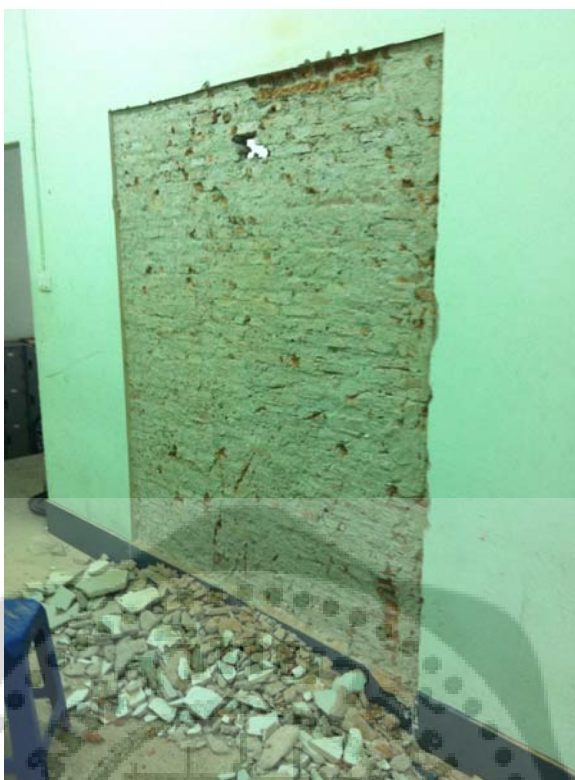
ภาพประกอบ 84 แสดงการเจาะประตูห้องเรียนใหม่บริเวณผนังด้านนอกของห้องเรียนต้นแบบ
