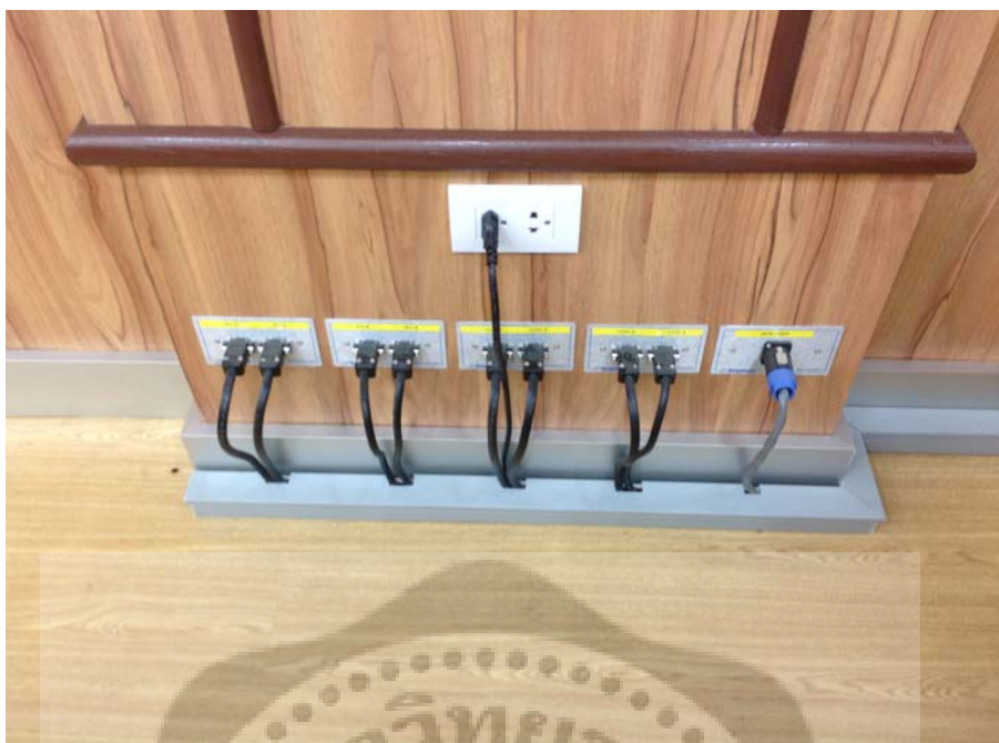
ภาพประกอบ 119 แสดงตำแหน่งของการเดินสายสัญญาณภาพและเสียง
