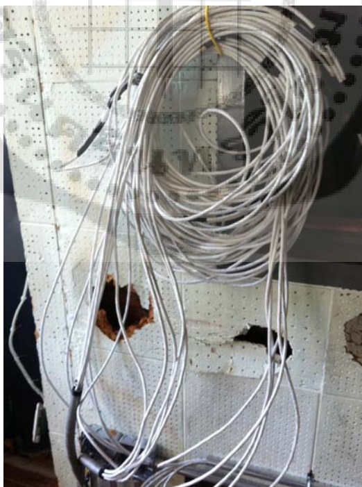
ภาพประกอบ 90 แสดงการเดินสายสัญญาณเน็ตเวิร์คบริเวณผนังห้องเรียนต้นแบบ
