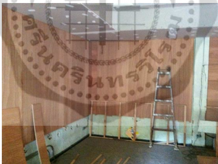
ภาพประกอบ 96 แสดงบริเวณผนังด้านหน้าของห้องเรียนต้นแบบที่บุด้วยไม้อัด
