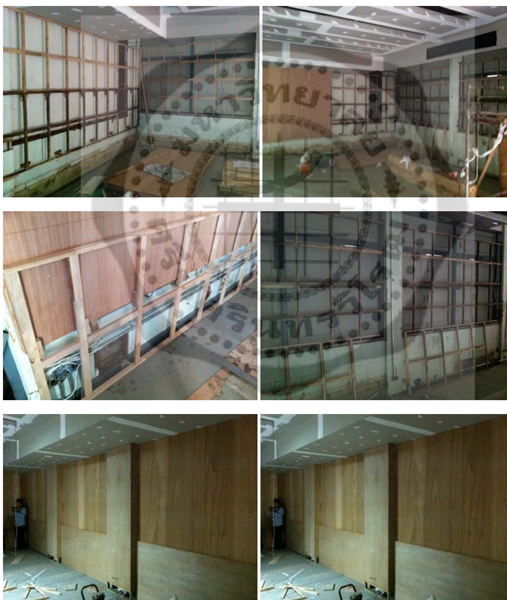
ภาพประกอบ 11 แสดงโครงสร้างและการติดตั้งผนังของห้องเรียนต้นแบบ
