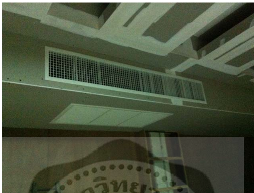
ภาพประกอบ 105 แสดงการติดตั้งแผงกระจายความเย็นของส่วนทำความเย็นพร้อมทั้งระบบ Return Air
