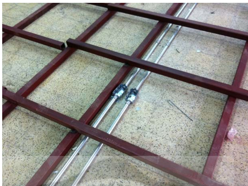
ภาพประกอบ 82 แสดงการเดินสายสัญญาณพร้อมไปกับการยกพื้นห้องเรียนต้นแบบ
