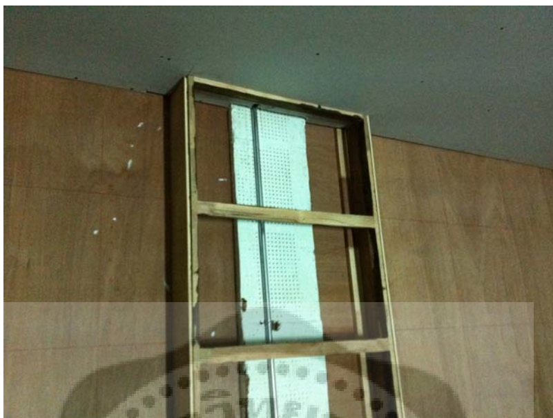
ภาพประกอบ 103 แสดงบริเวณการทำโครงคร่าวสำหรับการหุ้มเสาของห้องเรียน และการเดินท่อร้อยสาย ยึดติดกับผนังห้องเรียนต้นแบบ
