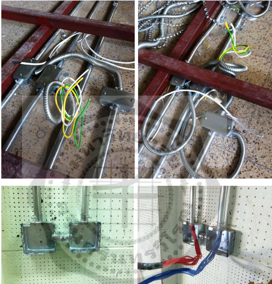
ภาพประกอบ 16 แสดงการเดินสายและติดตั้งระบบไฟฟ้าบนพื้นและผนังของห้องเรียนต้นแบบ
