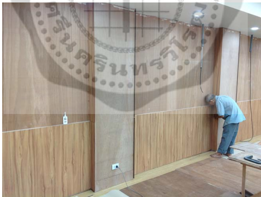
ภาพประกอบ 140 แสดงการติดตั้งผนังห้องเรียนต้นแบบ
