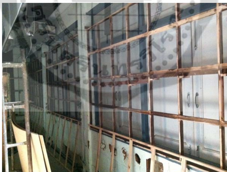
ภาพประกอบ 94 แสดงโครงคร่าวไม้บริเวณผนังด้านข้างของห้องเรียนต้นแบบ
