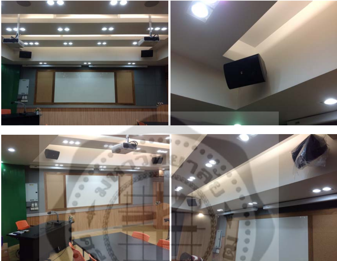
ภาพประกอบ 26 แสดงการติดตั้งลำโพงในห้องเรียนต้นแบบ
