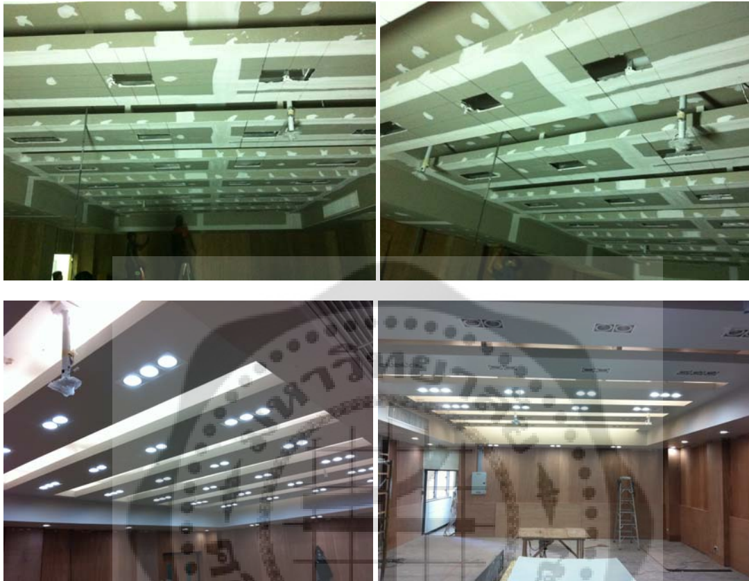
ภาพประกอบ 15 แสดงการติดตั้งระบบไฟแสงสว่างของห้องเรียนต้นแบบ
