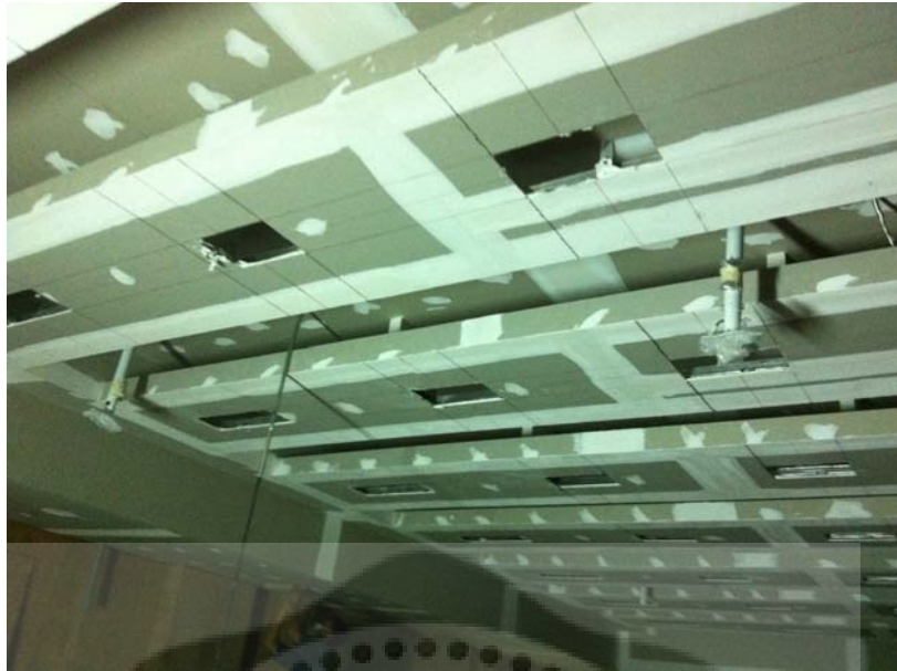
ภาพประกอบ 109 แสดงการติดตั้งสายสัญญาณของระบบฉายภาพและอุปกรณ์ในการยึดแขวนเครื่องฉายภาพ LCD Projector
