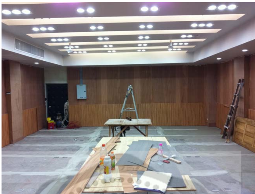
ภาพประกอบ 111 แสดงการทดสอบเปิดระบบไฟแสงสว่างภายในห้องเรียนทั้งแบบ Up light และ Down light
