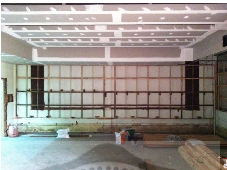
ภาพประกอบ 93 แสดงโครงคร่าวไม้ของผนังห้องเรียนต้นแบบบริเวณด้านหลังของห้องเรียนต้นแบบ
