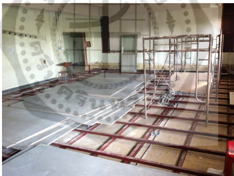
ภาพประกอบ 82 แสดงการเดินสายสัญญาณพร้อมไปกับการยกพื้นห้องเรียนต้นแบบ
