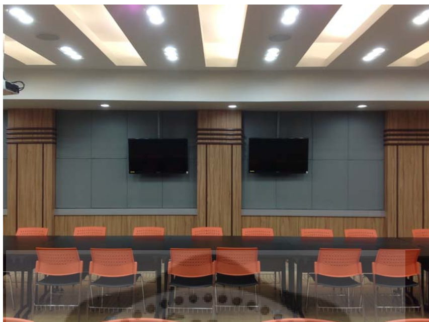
ภาพประกอบ 125 แสดงการทดสอบระบบไฟแสงสว่าง
