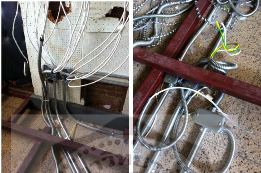
ภาพประกอบ 17 แสดงการเดินสายและติดตั้งระบบอินเทอร์เน็ต
