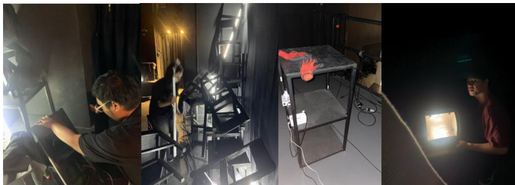
ภาพที่ 3.168 : เตรียมอุปกรณ์และการติดตั้ง
