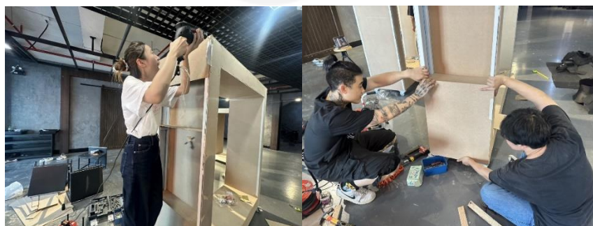
ภาพที่ 3.50 : ภาพการติดตั้งชั้นวาง
